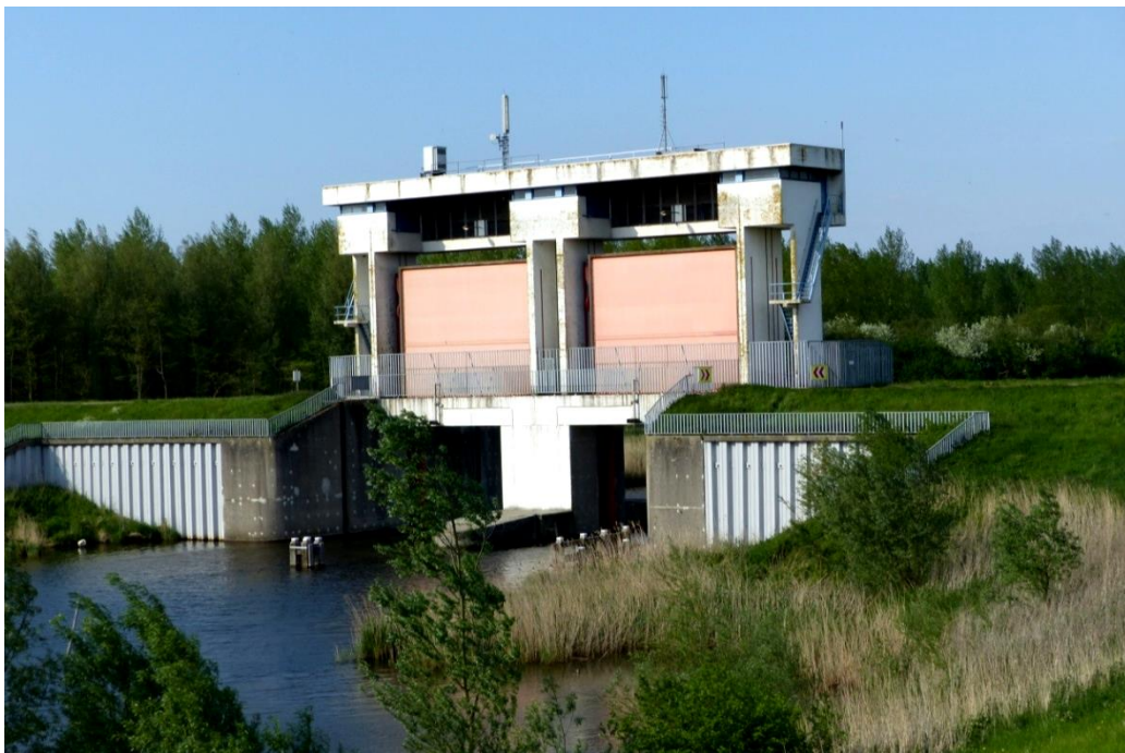
De Lage Knarsluis (foto Henk Pruntel).
