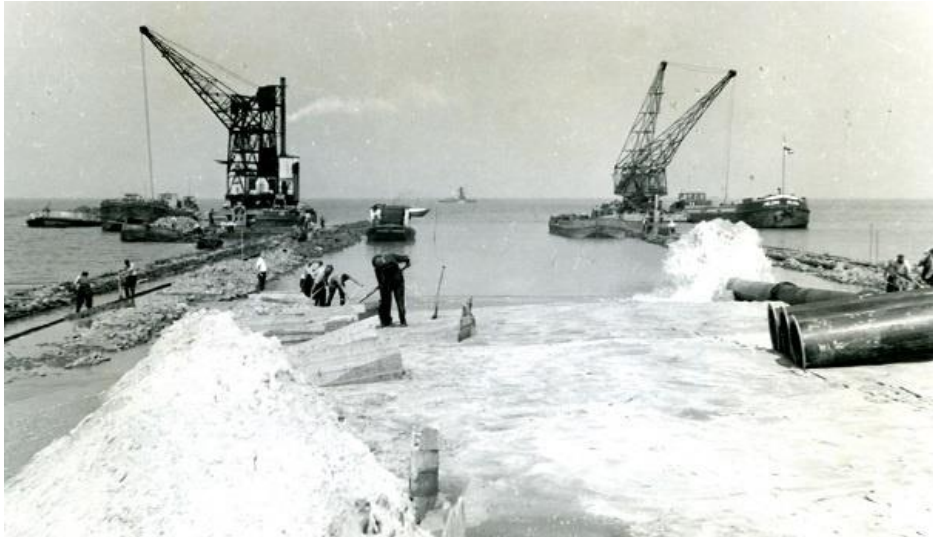
Bij de aanleg van de Knardijk wordt de ruimte tussen de beide keileemdammen opgevuld met zand, 22 juli 1952 (foto Jaap Potuyt).
