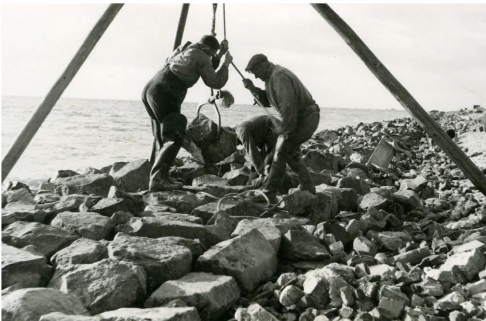
Steenzetters aan het werk met het ‘vlijen’ van zware stortstenen van 120 tot 300 kilo, 8 oktober 1952 (foto Jaap Potuyt).
